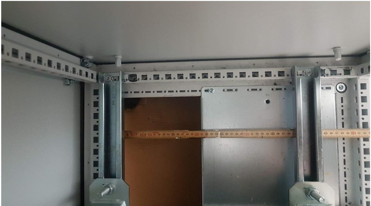
图 7 机柜底部的开口（内部俯视图）。大约有保持打开 1/3 的状态。
