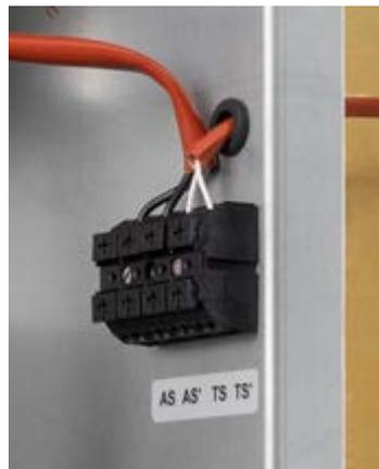
图 31 用于辅助触点连接的端子
