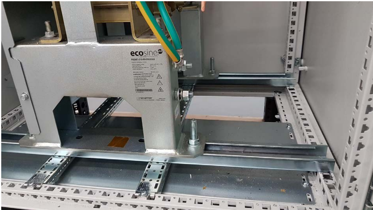
Abbildung 6 Öffnung an der Unter- und Rückseite des Schrankes (Vorderansicht)
