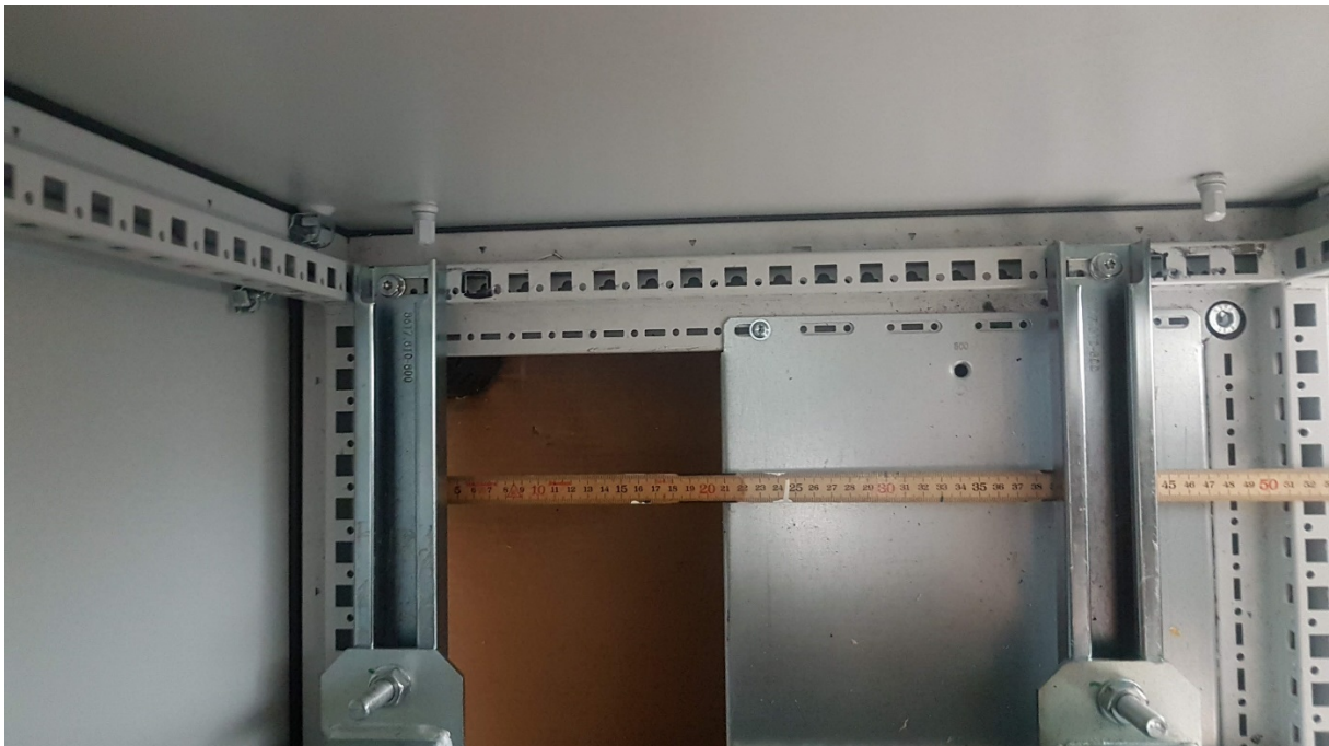
Abbildung 7 Öffnung an der Unterseite des Gehäuses (Draufsicht von innen). Etwa 1/3 bleibt offen.
