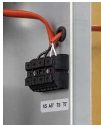
Abbildung 31 Klemme für Anschluss des Hilfskontakts
