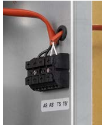
Figura 31 Morsetto per il collegamento dei contatti ausiliari
