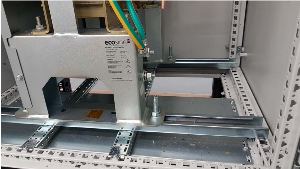
Figura 6 apertura sul fondo e sul retro del cabina (vista frontale)
